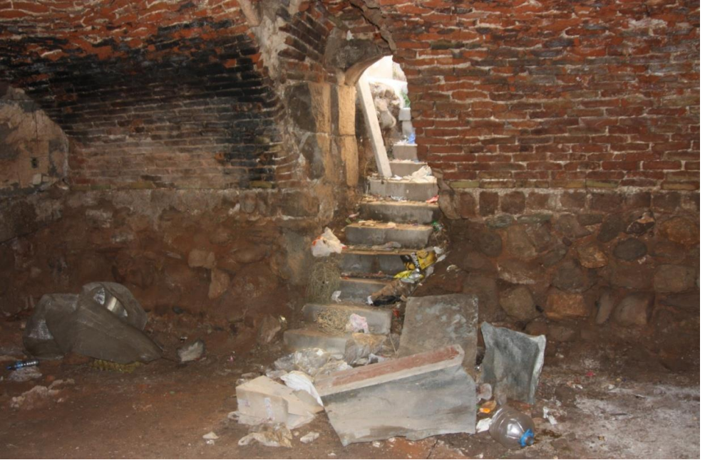
Fotoğraf 11: Çaput Baba Türbesi İç Mekan Doğudan Görünüş
