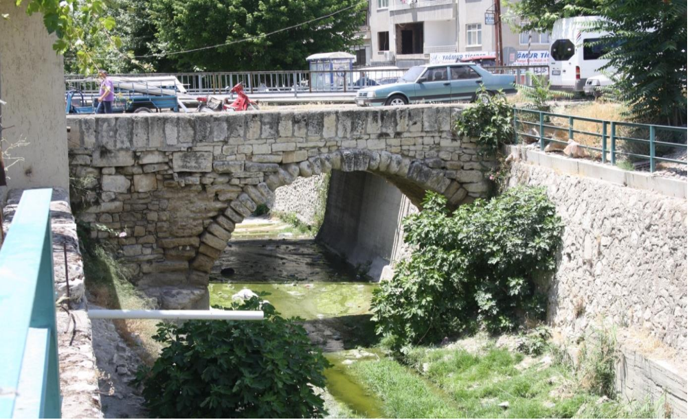
Fotoğraf-12. Taş Köprü genel görünüm.
