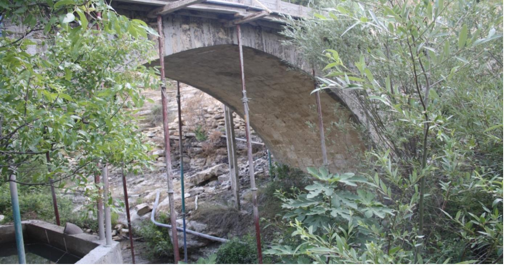
Fotoğraf-2. Eşekçi Köprüsü ayrıntı.
