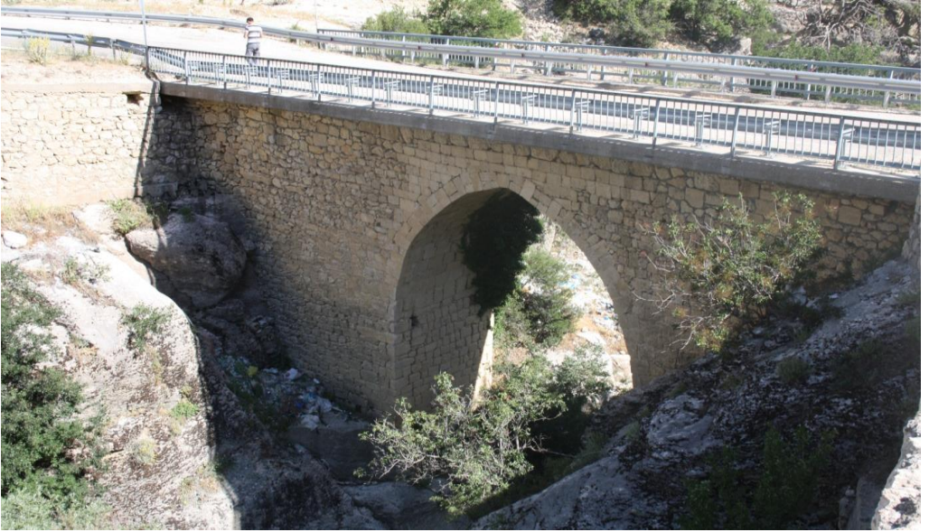
Fotoğraf-2. Arı Köprüsü kuzey cephe.
