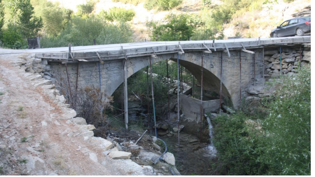
Fotoğraf-3. Eşekçi Köprüsü genel görünüm.
