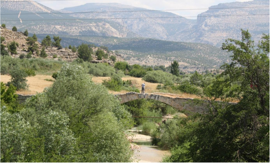
Fotoğraf-14. Yapıntı Köprüsü genel görünüm.
