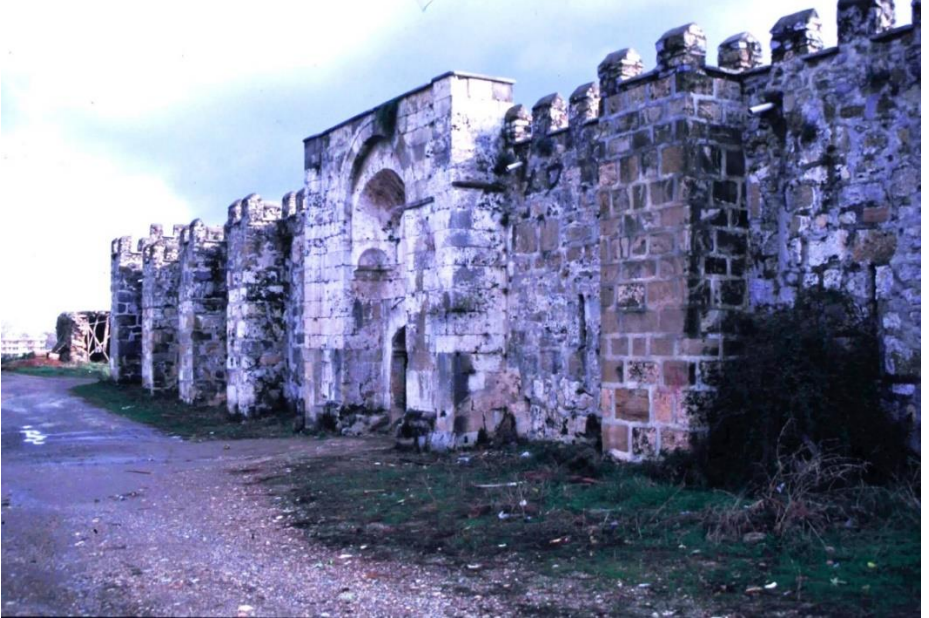
Fotoğraf-13: Şarapsa Han'ın Giriş Cephesi Görünüşü(O.Kunduracı).
