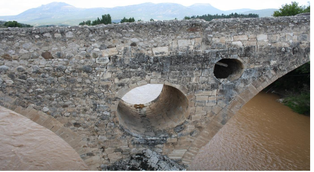
Fotoğraf-10. Kravga Köprüsü boşaltma gözleri.
