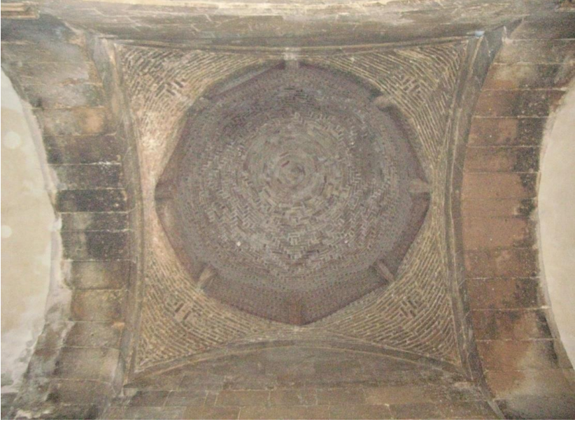
Resim. 7. Orta sahnındaki aydınlık fenerin kubbesi.
