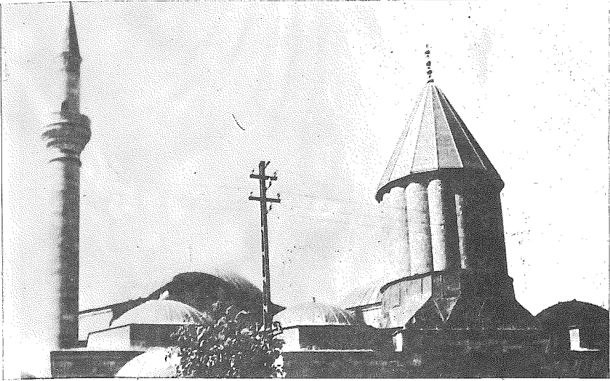
28. Resim: Kûlân'daki çinilerin yenilenmesi sırasında bu kısım zaman zaman ahşapla kaplanarak muhafaza altına alınmıştır.
