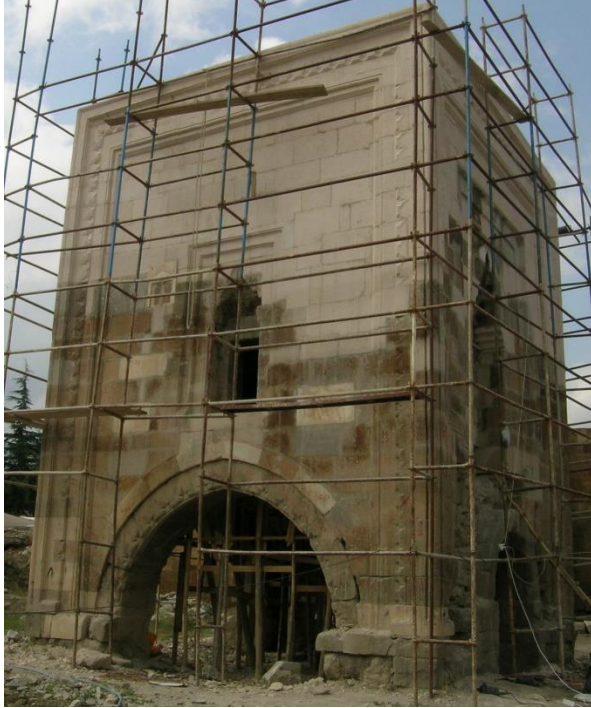
Foto 12: Köşk Mescit (Onarım Sonrası)
