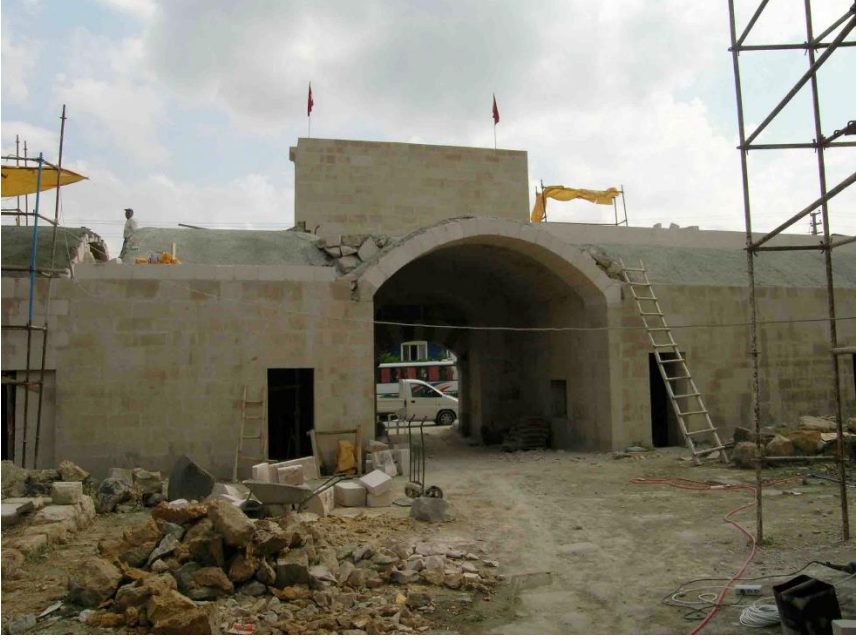
Foto 7: İshaklı Sâhib Ata Kervansarayı, Avlu Giriş Kanadı (Onarım)
