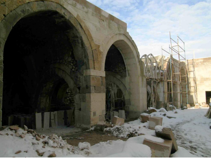
Foto 9: Avlu Kuzey Kanat (Onarım)
