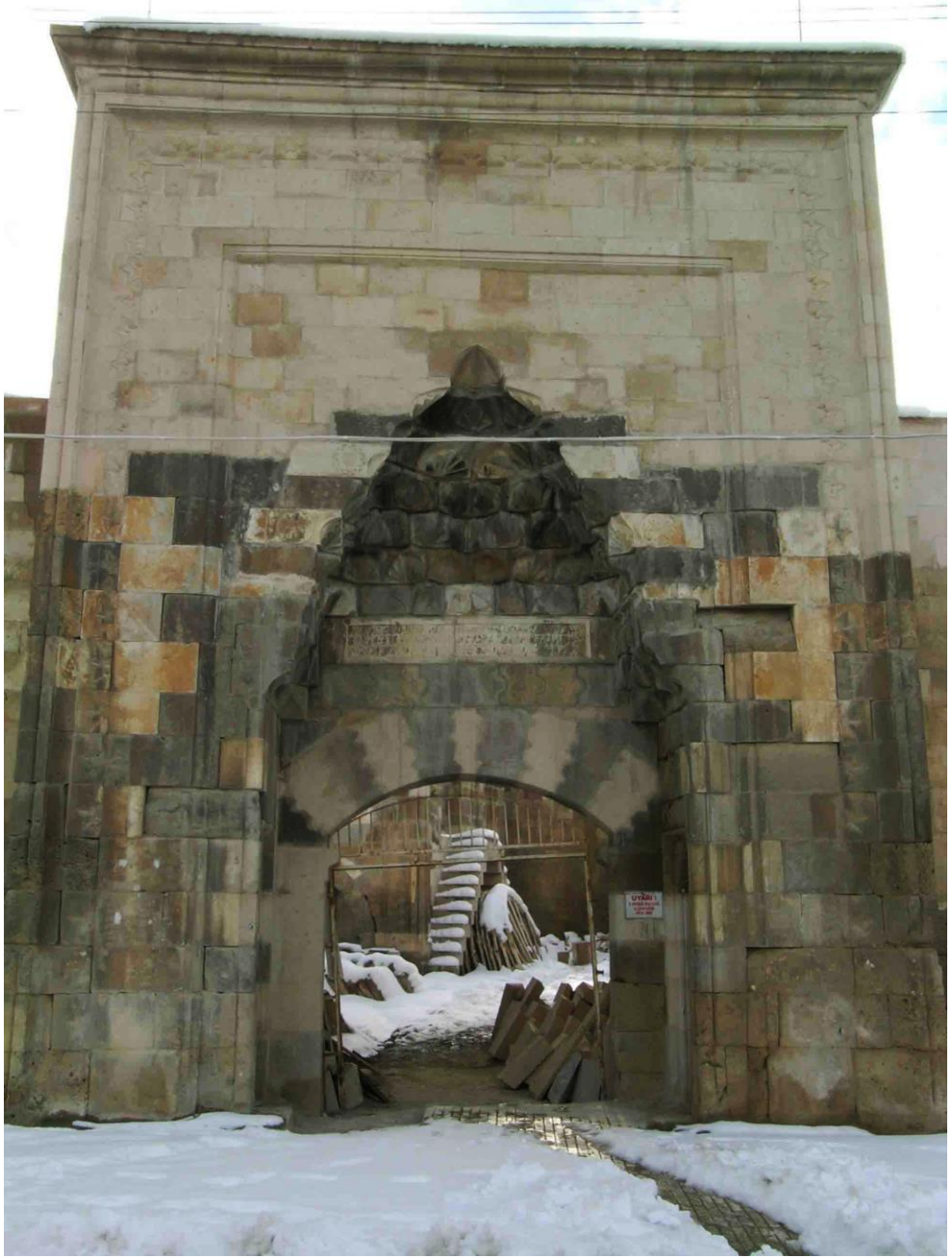
Foto 2: İshaklı Sâhib Ata Kervansarayı, Aolu Portali (Onarım Sonrası)
