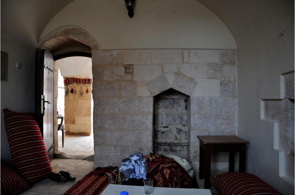
Fotoğraf 27. Hacı Sadık Ağa Hanı, I. Kattaki Odaların Kuzey Duvarı
