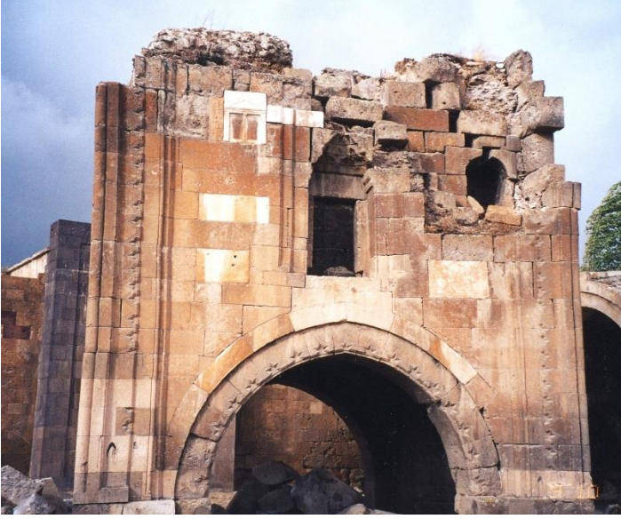
Foto 11: Köşk Mescit (Onarım Öncesi) (V.G.M. Arşivi'nden)
