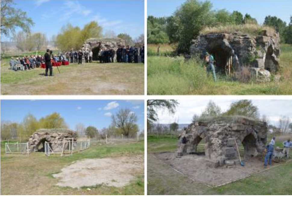
Fotoğraf 5. 2014 yılı sondaj çalışması. Dört Kemerli Yapı
