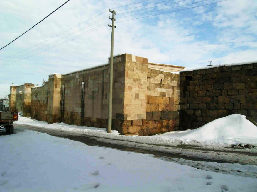
Foto 6: İshaklı Sâhib Ata Kervansarayı, Kuzey Cephe (Onarım Sonrası)
