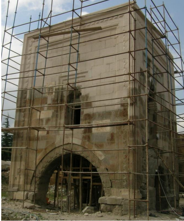
Foto 12: Köşk Mescit (Onarım Sonrası)
