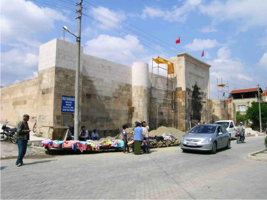
Foto 1: İshaklı Sâhib Ata Kervansarayı, Ön Cephe (Onarım Sonrası)
