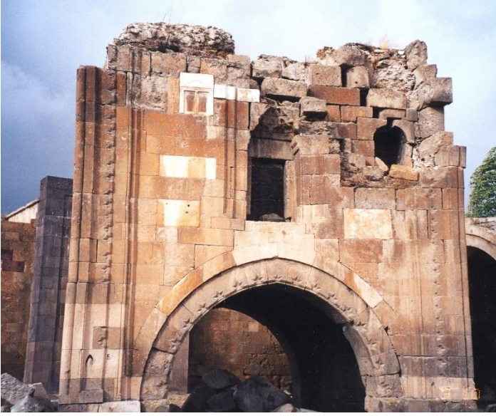
Foto 11: Köşk Mescit (Onarım Öncesi) (V.G.M. Arşivi'nden)
