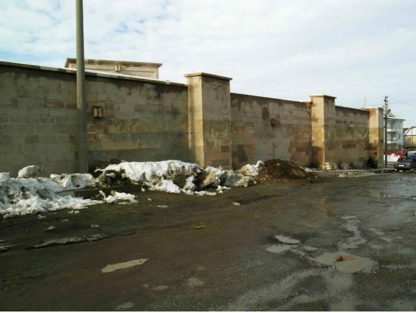
Foto 4: İshaklı Sâhib Ata Kervansarayı, Güney Cephe (Onarım Sonrası)
