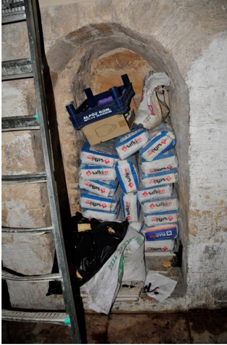
Fotoğraf 29. Hacı Sadık Ağa Hamam Zemin Kattaki Tuvalet
