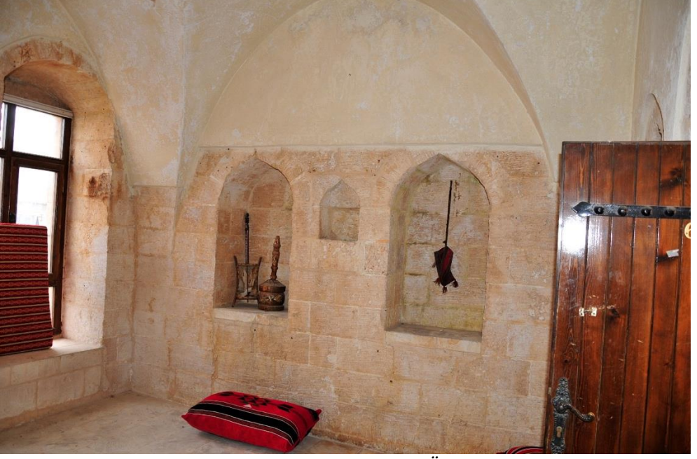
Fotoğraf 28. Hacı Sadık Ağa Hamam I. Kat, Giriş Eyvanı Üstündeki Odanın Batı Duvarı
