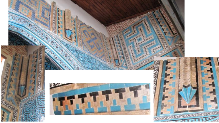
Fotoğraf 20: Sahip Ata Külliyesi hanıgah-türbe geçişi
